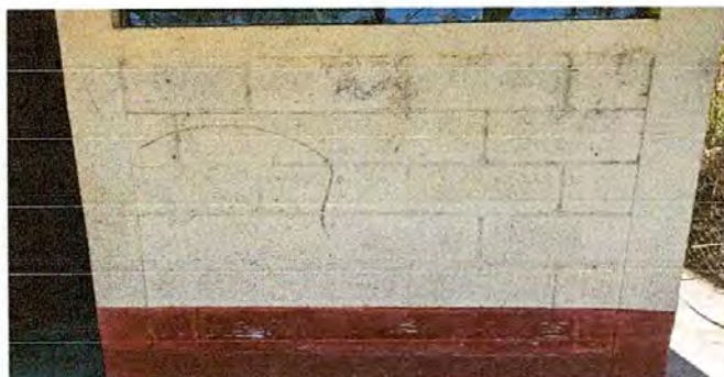
Pintura en muros exteriores e interiores
