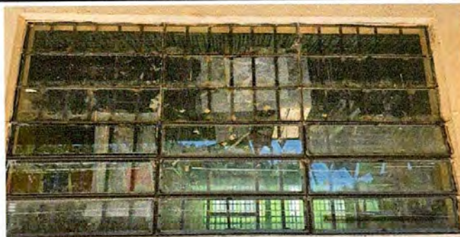
Sustitución de vidrios para ventanas
