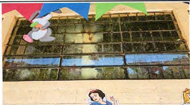
Sustitución de estructura de metal de ventana
