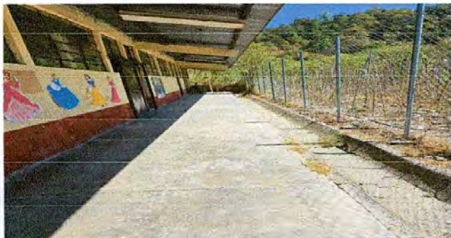
Sustitución de piso de cemento liquido en cocina y corredor
