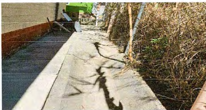
Reparación de cuneta de concreto
