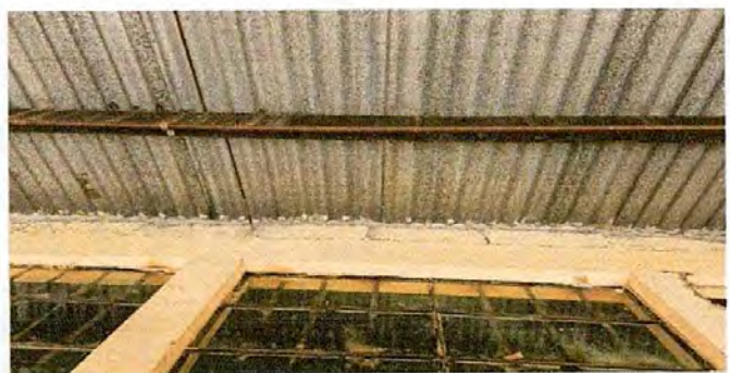
Mantenimiento a estructura de soporte de metal
