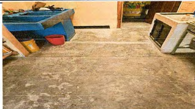
Sustitución de piso de cemento liquido en cocina y corredor
