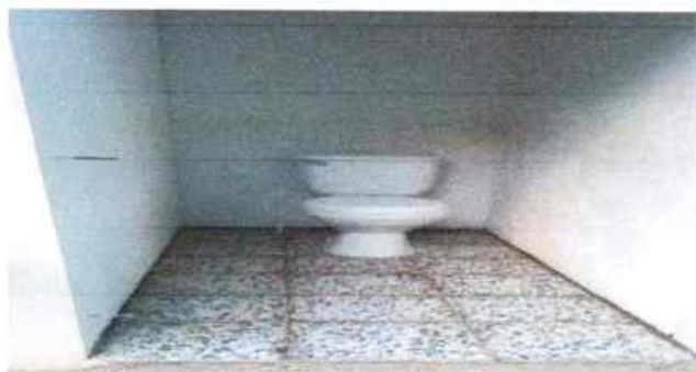
Foto1: SUSTITUCION DE INODOROS
