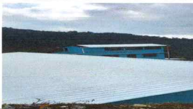
Foto 5: SUSTITUCIÓN DE TECHO EDIFICIO 2 O MODULO "B"
