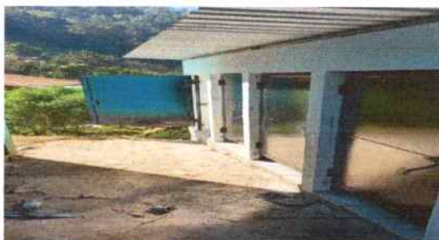
Foto 3: SUSTITUCIÓN DE TECHO Y MEJORAMIENTO DE SANITARIOS
