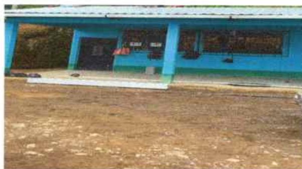
Foto 4: SUSTITUCIÓN DE TECHO EDIFICIO 1 O MODULO "A"
