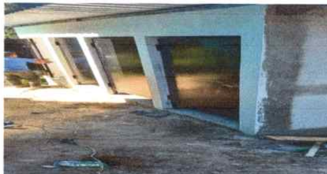
Foto 2: SUSTITUCIÓN DE PUERTAS O MANTENIMIENTO DE PUERTAS
