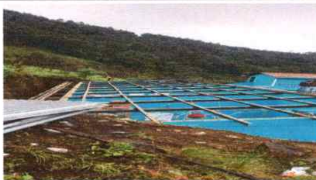
Foto 4: SUSTITUCIÓN DE TECHO EDIFICIO 1 O MODULO "A" Y "B"
