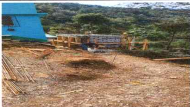
Foto 3: SUSTITUCIÓN DE TECHO Y MEJORAMIENTO DE SANITARIOS
