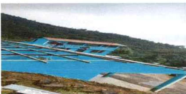
Foto 5: SUSTITUCIÓN DE TECHO EDIFICIO 2 O MODULO "B"
