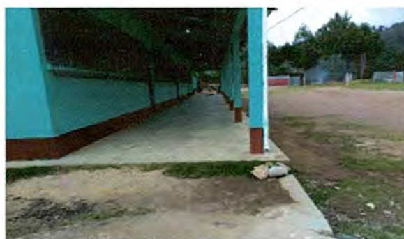
SE REALIZARÁ REPARACIÓN DE SISTEMA ELÉCTRICO
