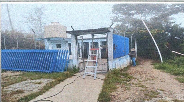
Foto 3. Reparacion de cerco de alambre a baranda
