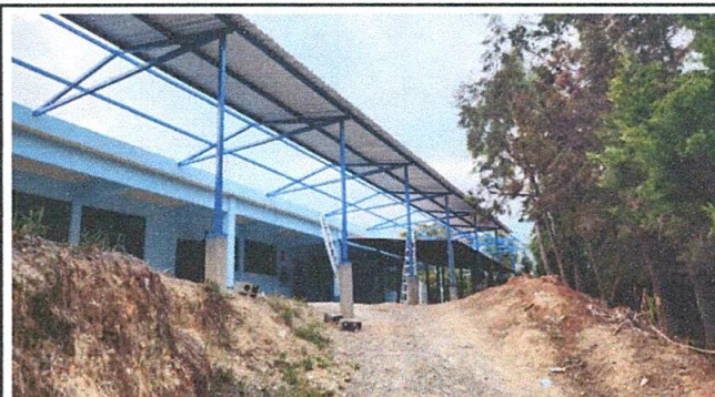
Foto 2. Sustitucion de techo
