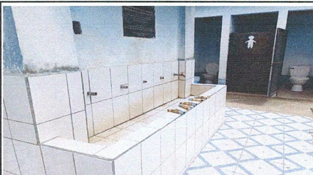
Foto 4. Reparacion de multichorros
