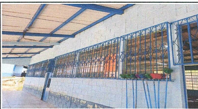
Foto 5. Reparacion de sustitucion de balcones.
