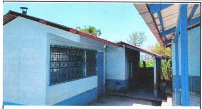
Foto 2. Sustitucion de techo
