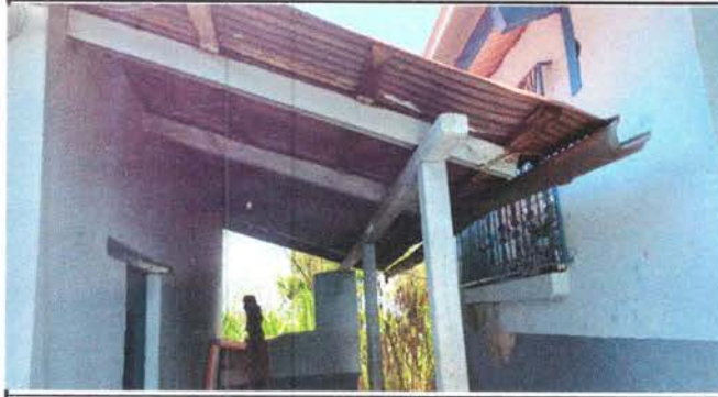
Foto 1. Sustitucion de estructura de Soporte
