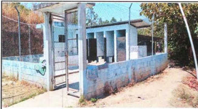
Foto 3. Reparacion de cerco de alambre a baranda
