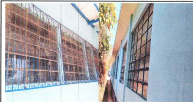
Foto 5. Reparacion de sustitucion de balcones.
