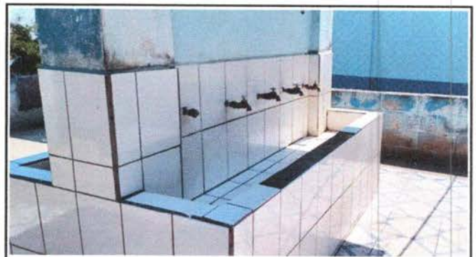
Foto 4. Reparacion de multichorros
