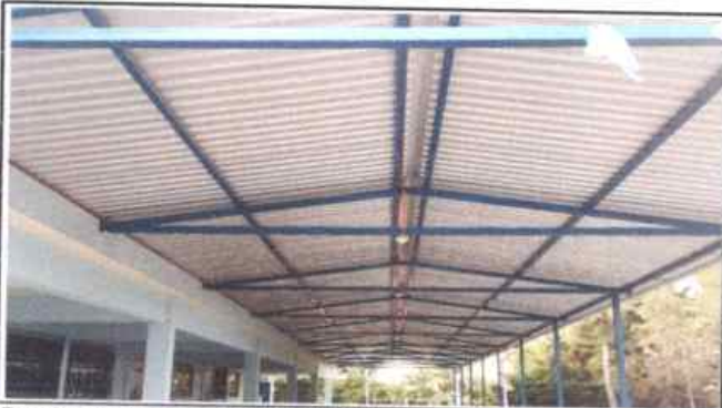
Foto 3: Sustrución del Sistema Elctrico
