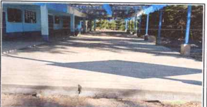
Foto 6: Sustrución de piso de concreto
