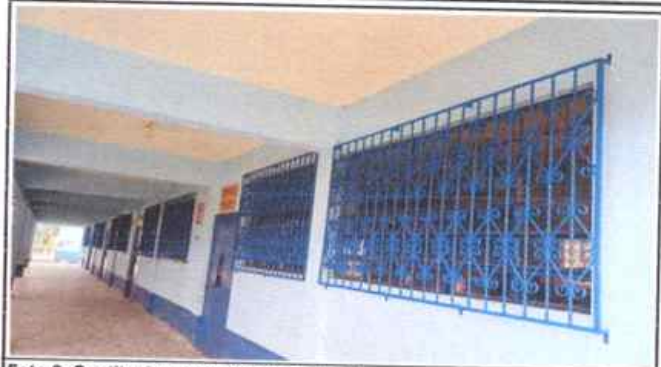
Foto 2: Sustrución de balcones de metal
