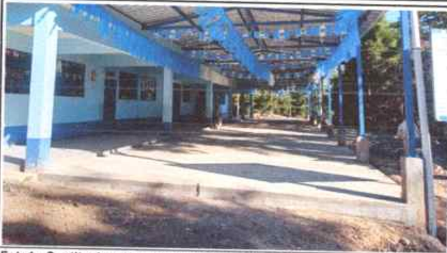
Foto 1: Sustrución de pios de torta de concreto
