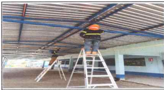
Foto 5: Mano de obra de electricista
