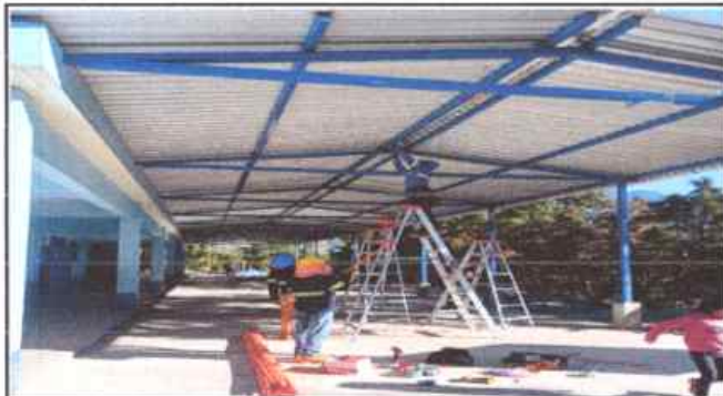
Foto 3: Sustitucion de Sistema Elecirico
