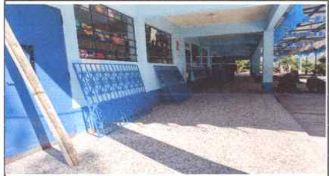
Foto 2: Sustitucion de balcones de metal
