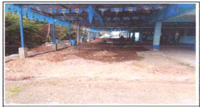
Foto 6: Sustitución de pios de concreto
