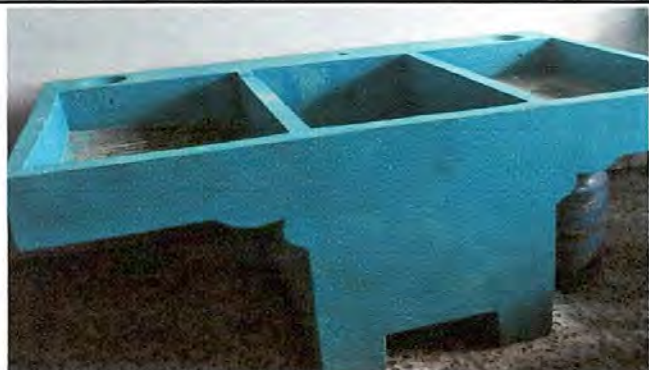
Foto 13: instalación de pila de cemento de dos lavadero.
