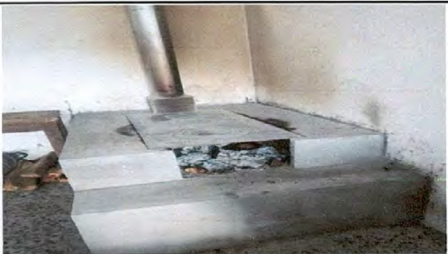
Foto 11: instalación de estufa rural (completa) incluye chimenea y plancha de metal.
