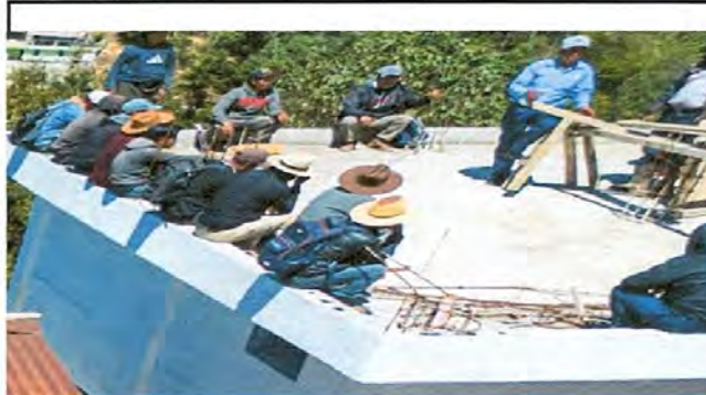
Foto 14: mano de obra.
