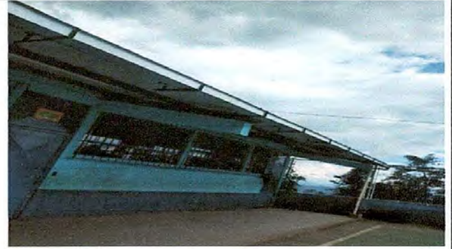
Foto 8: instalación de canal de metal.
