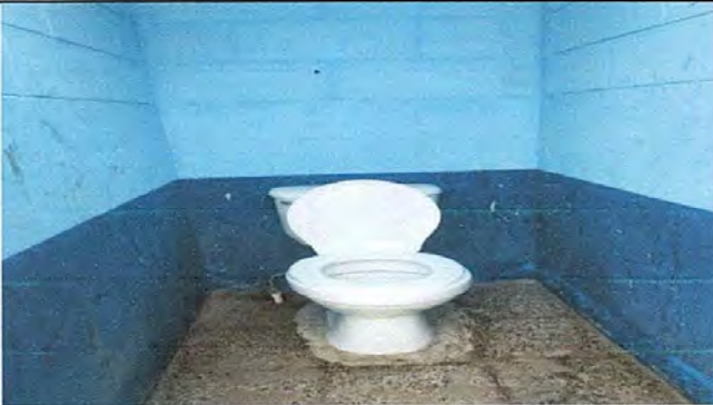
Foto 9: instalación de inodoro.
