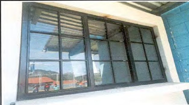
Foto 5: instalación de vidrio de 5x5.
