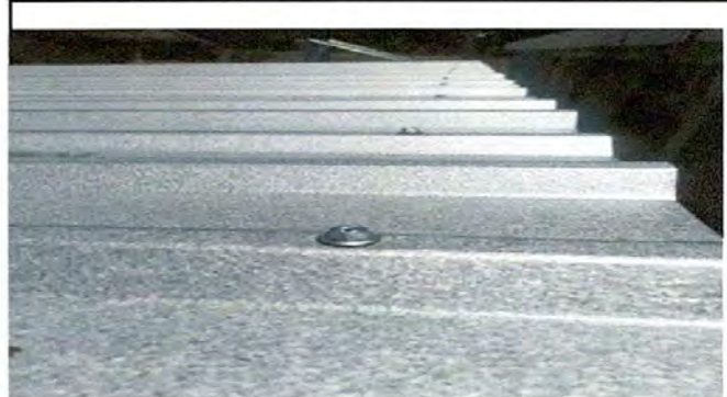
Foto 2: instalación de tornillos.
