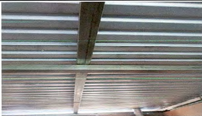
Foto 3: instalación de estructura de soporte de metal por metal.
