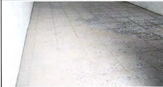
Foto 7: instalación de piso de granito.
