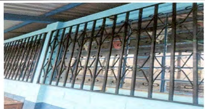
Foto 6: instalación de balcones de metal con angular de 1 pulgada y tubo cuadrado de 3/4.
