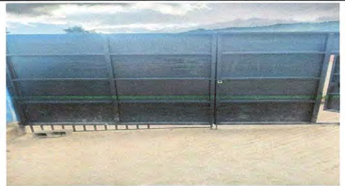
Foto 10: instalación de portón de metal.
