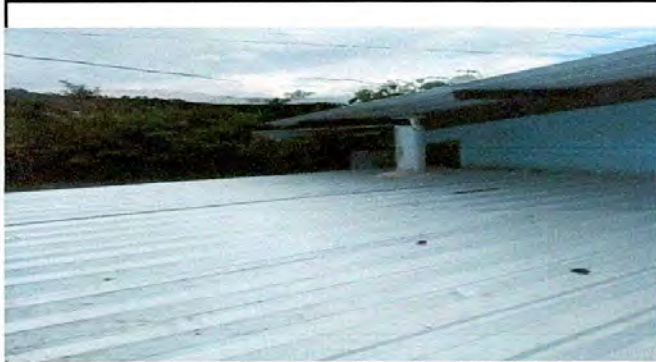
Foto 1: intalación de lámina troquelada calibre 26.
