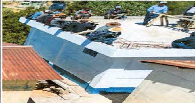
MANO DE OBRA TECHO
