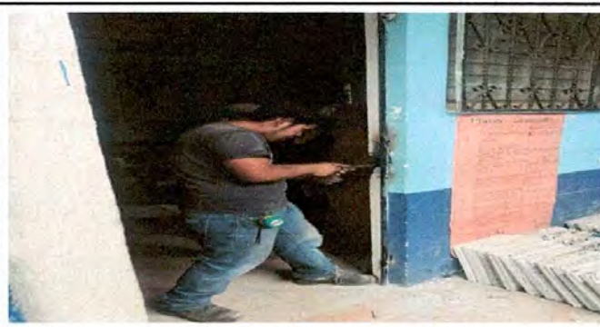
SUSTITUCIÓN DE PUERTA CON CHAPA 2.13 POR 98M
