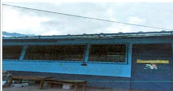
SUSTITUCIÓN DE CANAL DE METAL
