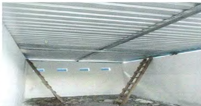
SUSTITUCIÓN DE LÁMINA TROPQUEALADA CALILBRE 26
