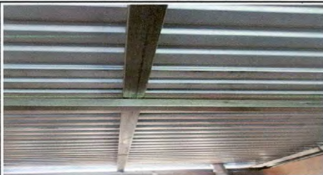
SUSTITUCIÓN DE ESTRUCTURA DE SOPORTO DE METAL POR METAL
