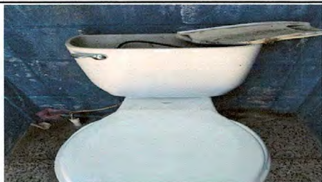
SUSTITUCIÓN DE INODORO
