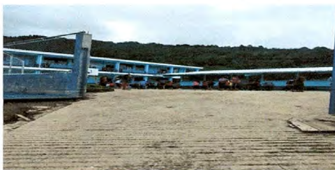
SUSTITUCIÓN DE PORTÓN DE METAL
