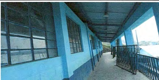
SUSTITUCIÓN DE BALCONES DE METAL CON ANGULAR DE 1 PULGADAY TUVO CUADRADO DE 3/4
