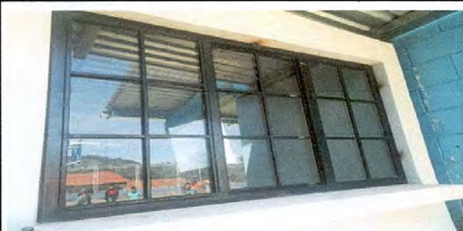
SUSTITUCIÓN DE VIDRIO DE 5X5
