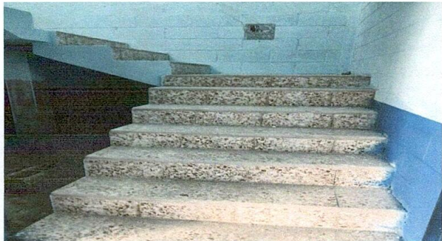
Foto 1: finalización de colocación de piso granito
