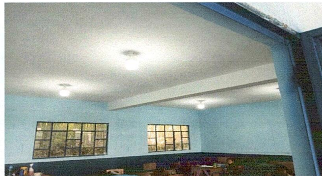
Foto 2: Finalización de las instalaciones de focos ahorradores
