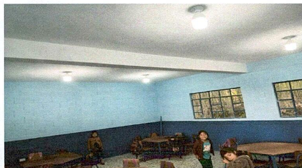
Foto 5: Finalización de colocación de ventanas
