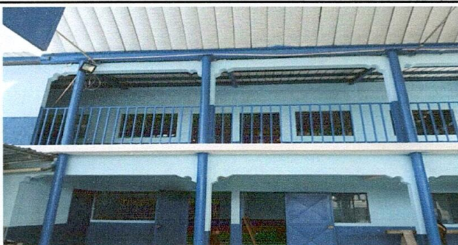
Foto 6: Finalización de colocación de varanda
