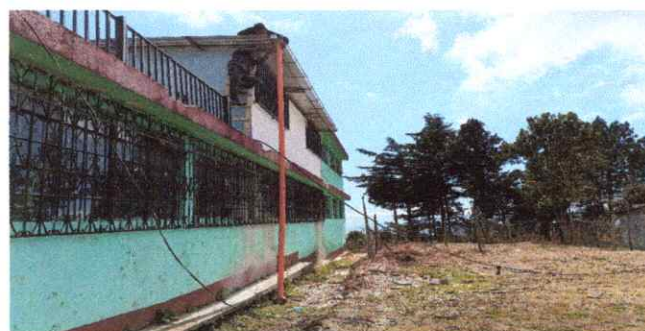
Foto 6: Canales y bajadas de agua Pluvial
