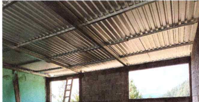
Foto 2: Estructura de Techo
