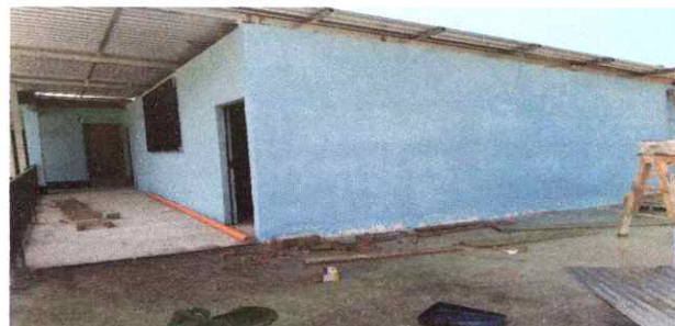
Foto 2: Pintura en muros exteriores e interiores
