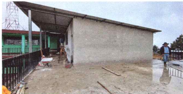
Foto1: cubierta de lámina
