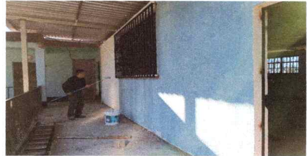
Foto 2: Pintura en muros exteriores e interiores
