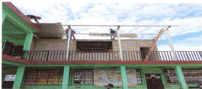
Foto1: cubierta de lámina
