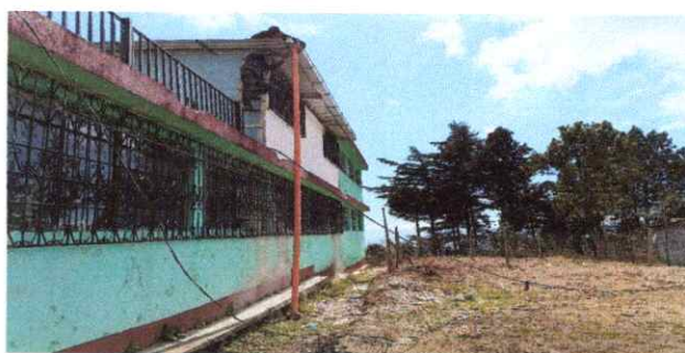
Foto 6: Canales y bajadas de agua Pluvial
