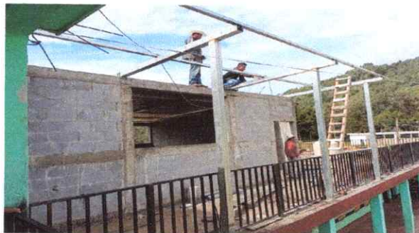
Foto 2: Estructura de Techo
