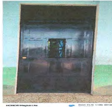
Foto: Sustitución de Puertas de aulas Primer Piso
