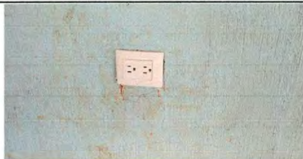
Foto 14: Sustrucción de tomacorrientes dobles
