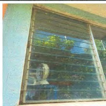
Foto 4: Sustitución de vidrios en aulas
