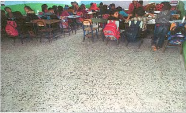
Foto 7: Sustitución de Piso de granito en aulas
