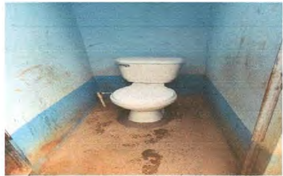
Foto 10: Sustitución de inodoro
