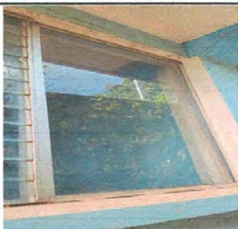
Foto 5: Sustitución de vidrios en aulas
