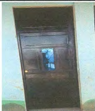
Foto 3: Sustitución de Puerta en Dirección
