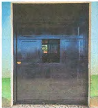
Foto 1: Sustitución de Puertas de aulas Segundo Piso
