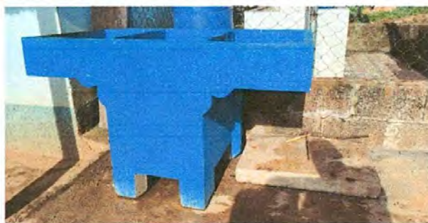
Foto 15: Sustrucción de pila de cemento de dos lavadero
