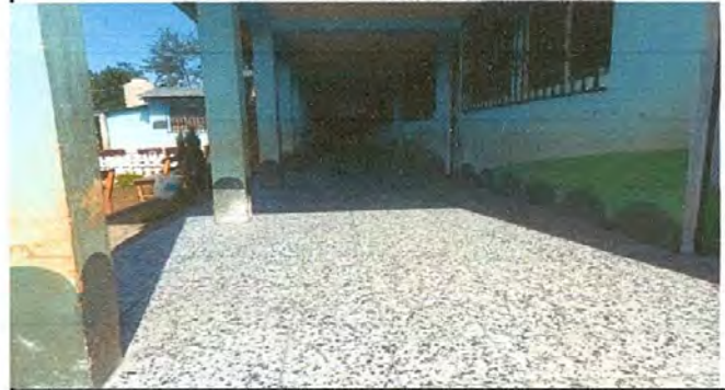
Foto 8: Sustitución de piso granito en corredor
