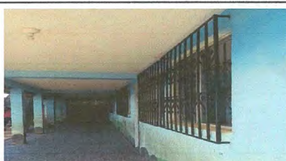
Foto 6: Mantenimiento a Balcones de Metal en aulas
