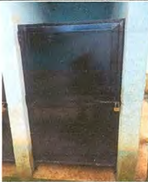
Foto 9: Mantenimiento a estructura de puertas servicios sanitarios
