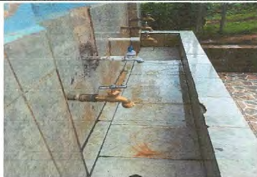
Foto 12: Sustitución de llave de chorro
