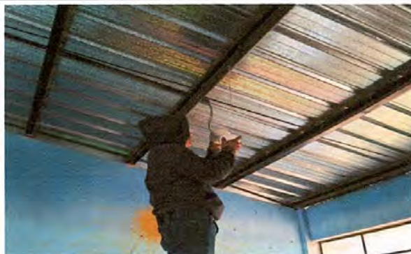
Foto 13: Sustitución de focos ahorradores y plafoneras
