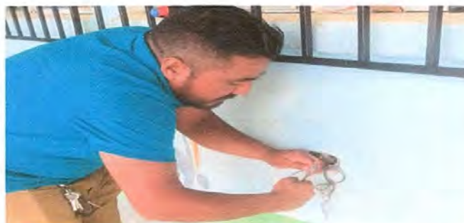
Foto 14: Sustitución de tomacorrientes dobles
