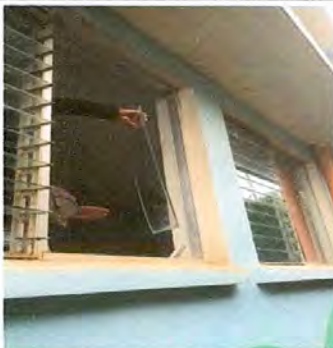
Foto 5: Sustitución de vidrios en aulas
