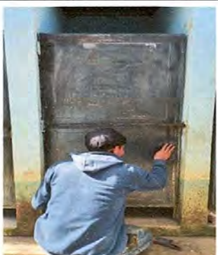
Foto 9: Mantenimiento a estructura de puertas servicios sanitarios
