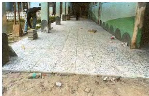
Foto 8: Sustitución de piso granito en corredor
