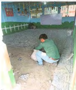
Foto 7: Sustitución de Piso de granito en aulas
