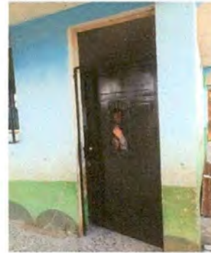
Foto: Sustitución de Puertas de aulas Primer Piso
