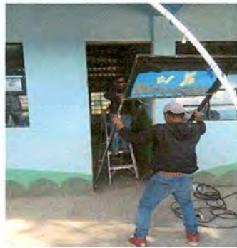
Foto 3: Sustitución de Puerta en Dirección
