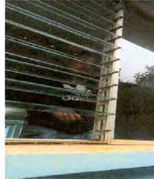
Foto 4: Sustitución de vidrios en aulas
