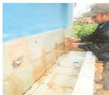
Foto 12: Sustitución de llave de chorro
