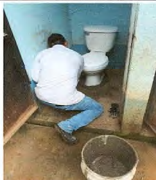
Foto 10: Sustitución de inodoro
