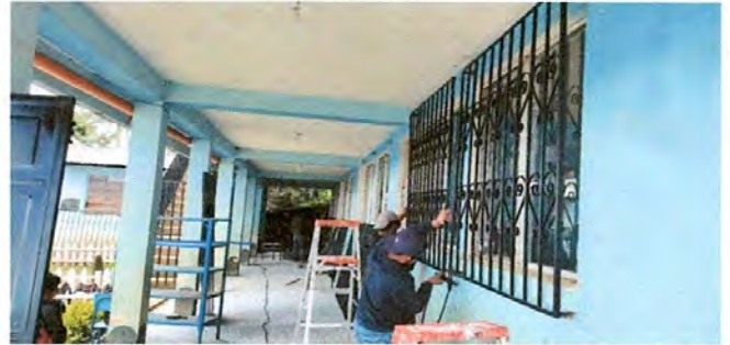
Foto 6: Mantenimiento a Balcones de Metal en aulas
