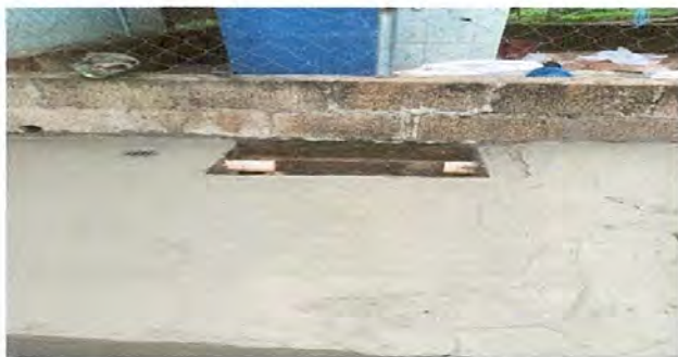
Foto 11: Sustitución de tubería aguas pluviales y caja de registro
