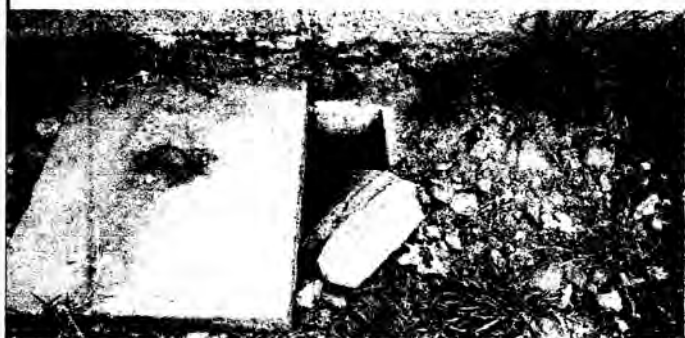
Foto 11: Sustrucción de tubería aguas pluviales y caja de registro
