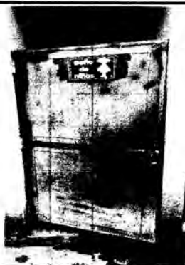
Foto 9: Mantenimiento a estructura de puertas servicios sanitarios
