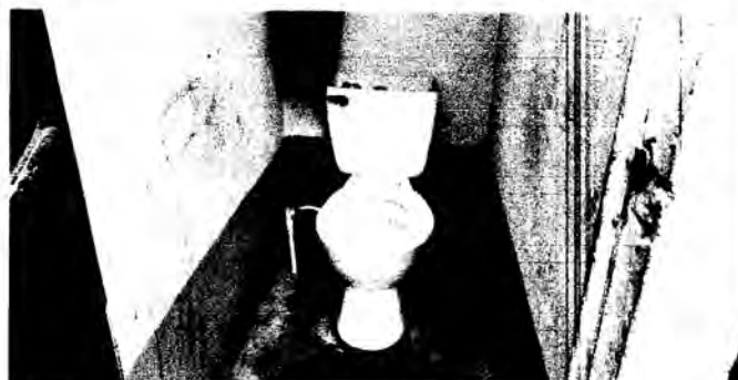
Foto 10: Sustrucción de inodoro
