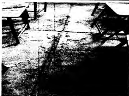
Foto 7: Sustrucción de Piso de granito en aulas
