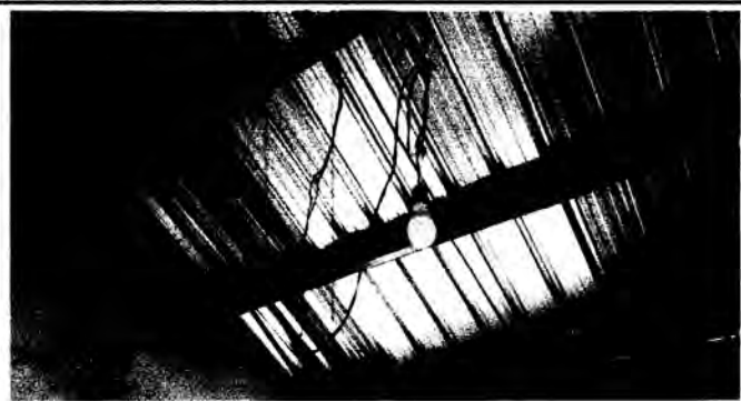
Foto 13: Sustrucción de focos ahorradores y plafoneras
