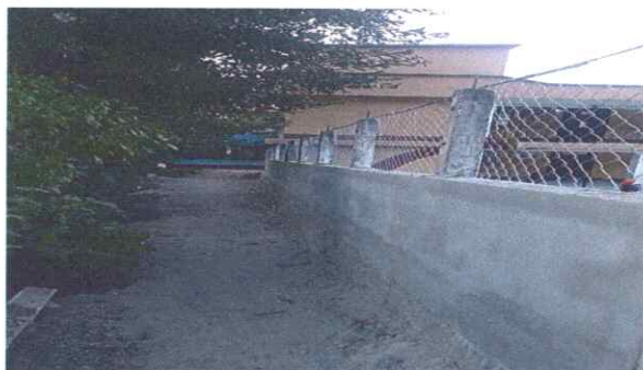
Foto 5: 100% FINALIZACIÓN DEL MURO PERIMETRAL.
