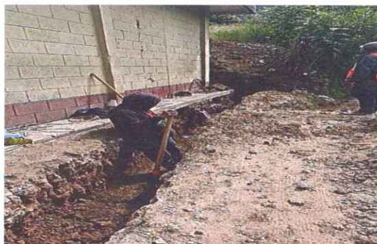
Foto 4: ESCABACIÓN DEL CIMIENTO DEL MURO DE CONTENCIÓN.
