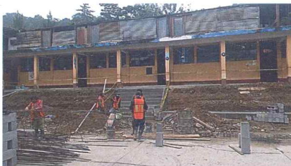
Foto 5: GRADERIOS EN CONSTRUCCIÓN.
