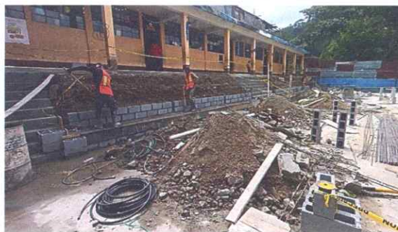
Foto 6: 30% DEL AVANCE DE LOS GRADERIOS.
