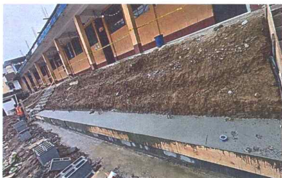
Foto 3: 15 % DEL AVANCE DE GRADERIOS.
