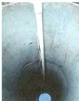
Foto 11: Sustitución de bomba sumergible
