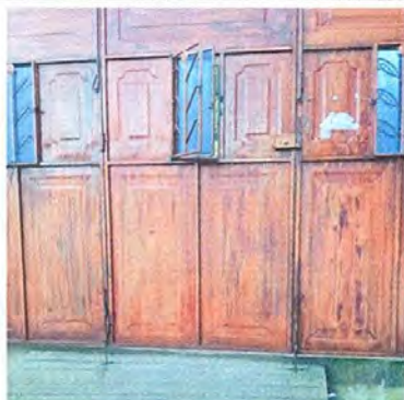
Foto 7: Mantenimiento de portones
