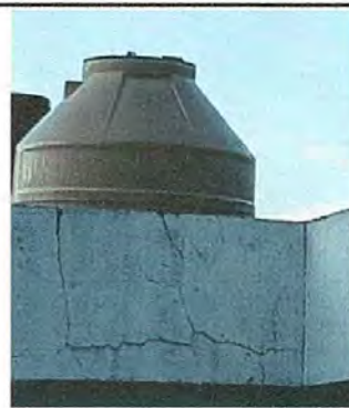
Foto 10: Sustitución de depósito de agua
