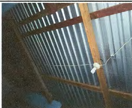
Foto 9: Reparación de sistema eléctrico
