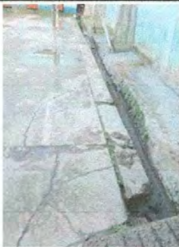
Foto 5: Cuneta de concreto
