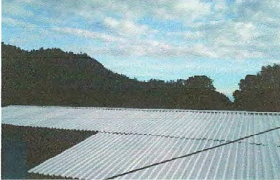
Foto 1: Cubierta de lámina
