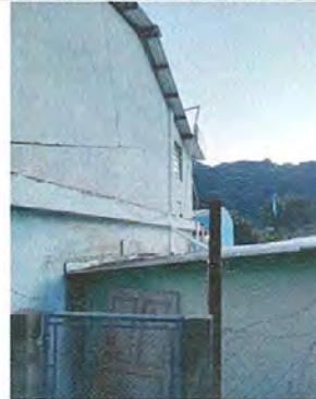
Foto 8: Red de agua potable
