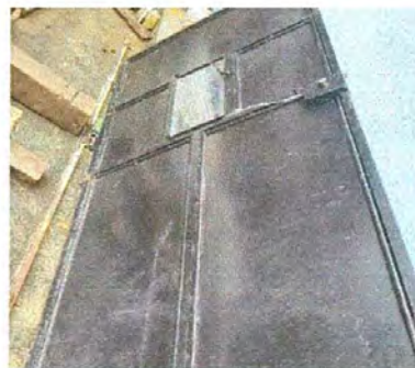
Foto 2: Puertas de metal
