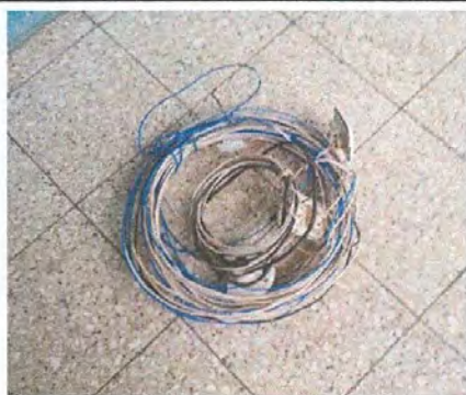
Foto 9: Reparación de sistema eléctrico
