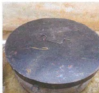
Foto 11: Sustitución de bomba sumergible
