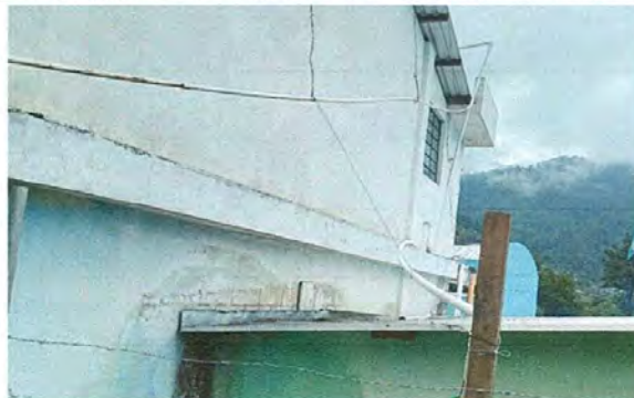
Foto 8: Red de agua potable
