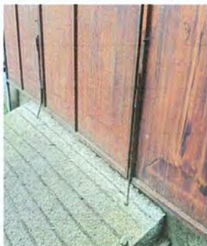
Foto 7: Mantenimiento de portones
