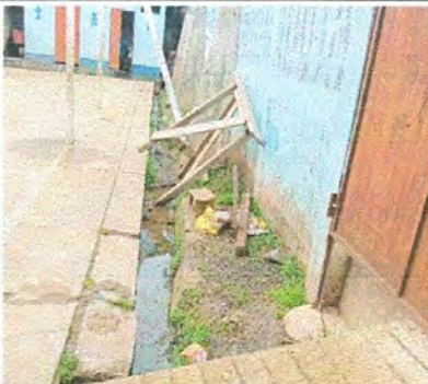
Foto 5: Cuneta de concreto
