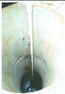
Foto 11: Sustitución de bomba sumergible
