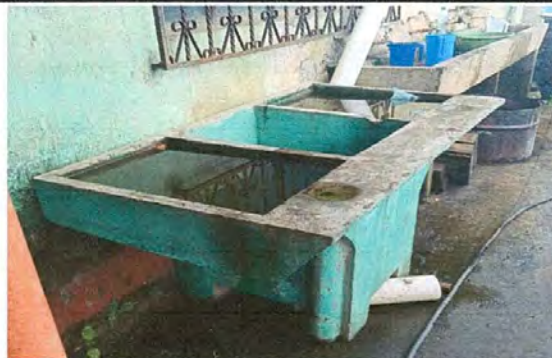
Foto 12: Sustitución de pila de 2 lavadero
