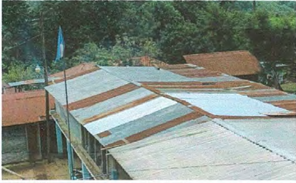
Foto 1: Cubierta de lámina
