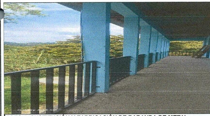
FOTO 5: SUSTITUCIÓN Y FABRICACIÓN DE BARANDA DE METAL
