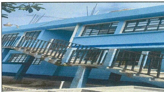
FOTO 4: MANTENIMIENTO A BARANDAS DE METAL EXISTENTES
