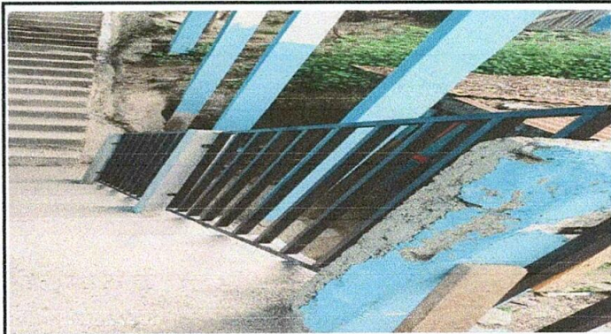
FOTO 3: PINTURA EN MUROS EXTERIORES E INTERIORES
