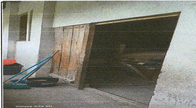
FOTO 2: SUSTITUCIÓN DE PUERTAS DE MADERA POR METAL
