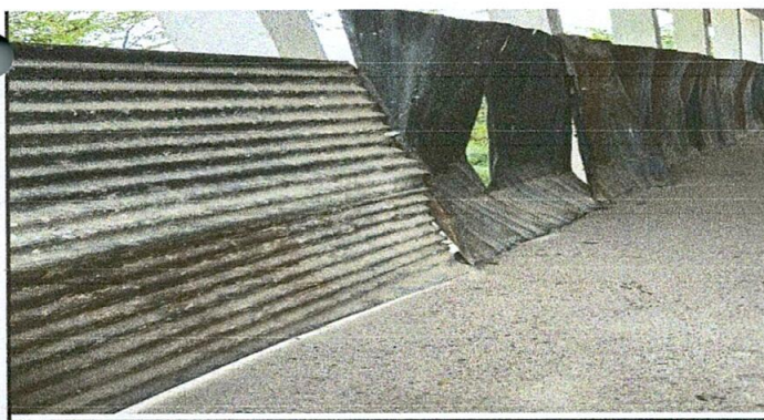
FOTO 5: SUSTITUCIÓN Y FABRICACIÓN DE BARANDA DE METAL
