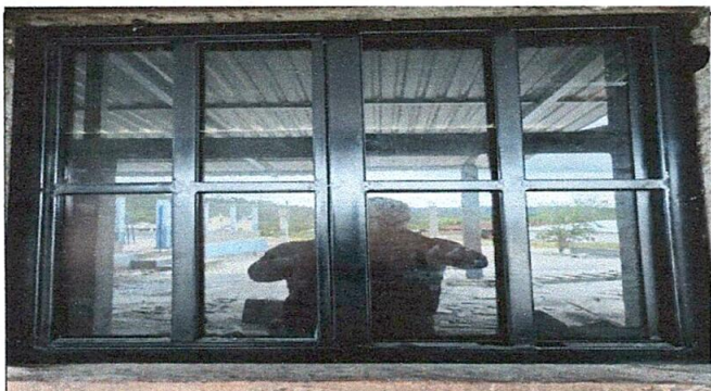
F3. Sustitución de ventanas
