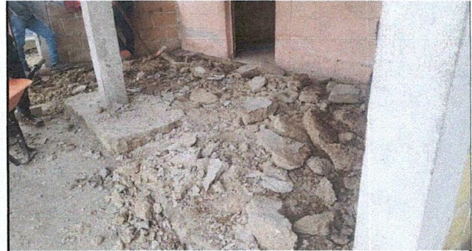
F. 4 Reparación de piso de torta de concreto
