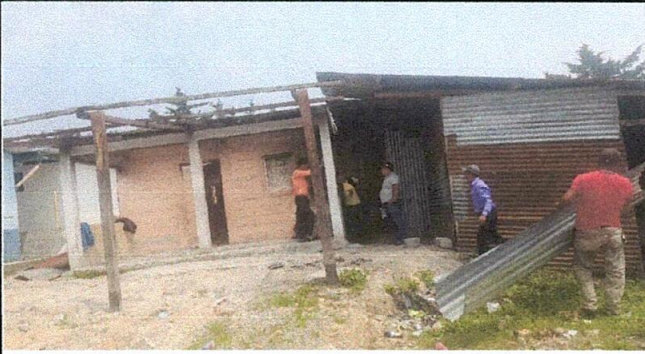
F. sustitución de láminapor lámina troquelada
