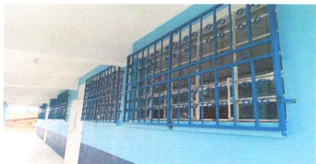
Foto1: SUSTITUCIÓN DE BALCONES DE METAL
