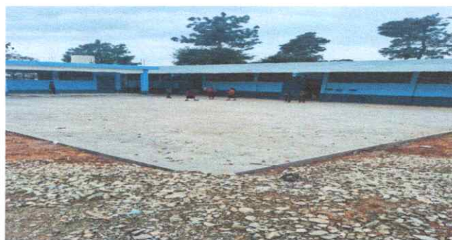
Foto 5: REPARACIÓN EN PLANCHA DE CONCRETO
