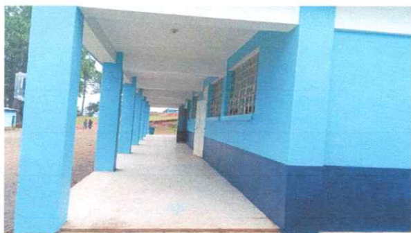
Foto 3: PINTURA EN MUROS EXTERIORES E INTERIORES
