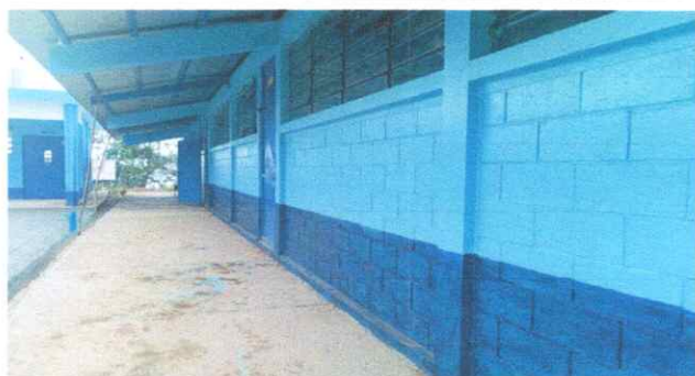
Foto 4: PINTURA EN MUROS EXTERIORES E INTERIORES
