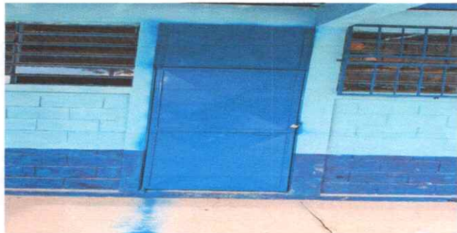
Foto 6: REPARACIÓN DE PINTURA EN PUERTAS
