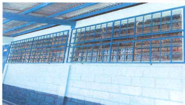
Foto 2: SUSTITUCIÓN DE BALCONES DE METAL
