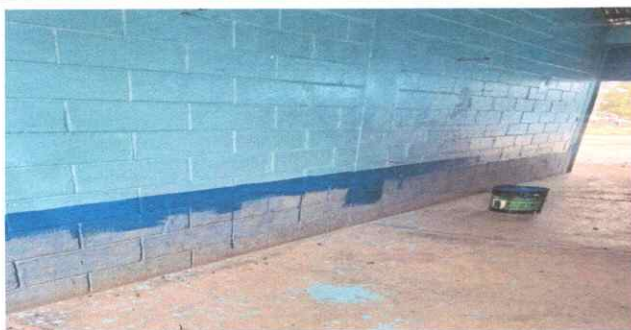
Foto 3: PINTURA EN MUROS EXTERIORES E INTERIORES
