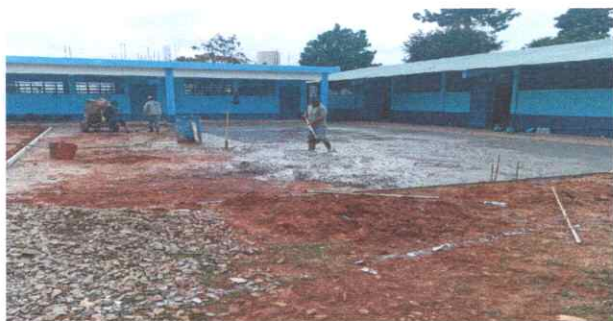
Foto 5: REPARACIÓN DE PLANCHA DE CONCRETO
