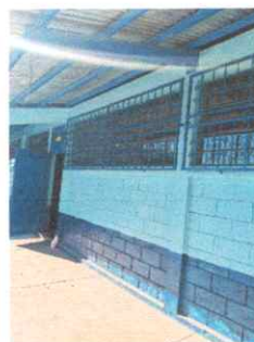
Foto 6: REPARACIÓN DE PINTURA EN PUERTAS
