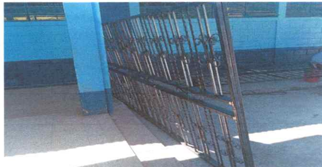
Foto 2: SUSTITUCIÓN DE BALCONES DE METAL
