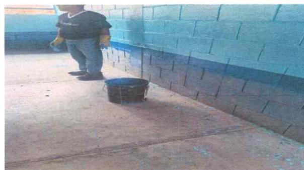
Foto 4: PINTURAS EN MUROS EXTERIORES E INTERIORES
