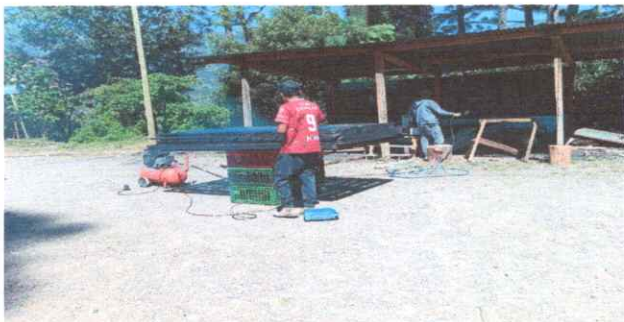
Foto1: SUSTITUCIÓN DE BALCONES DE METAL
