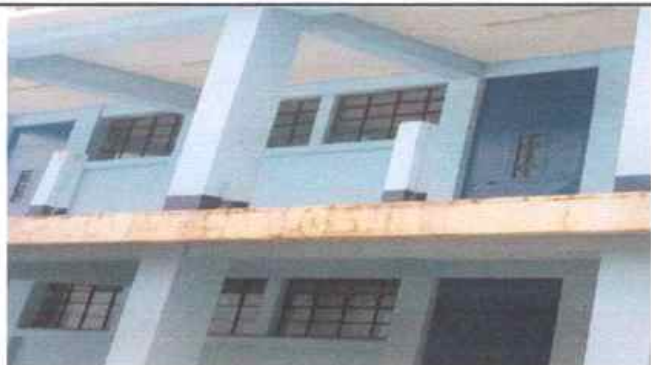
FOTO 1: MANTENIMIENTO A PUERTAS
