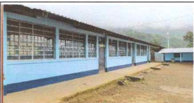
FOTO 5: PINTURA EN MUROS
