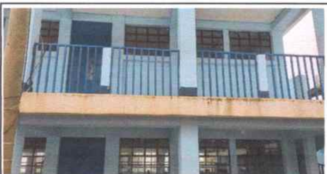
FOTO 6: SUSTITUCIÓN DE BARANDA DE METAL
