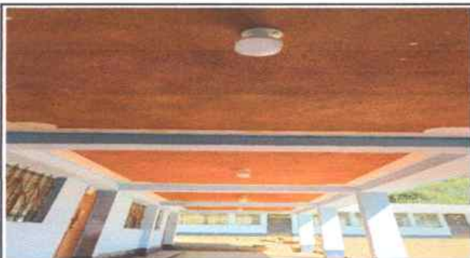
FOTO 3 CAMBIO DE PLAFONERAS
