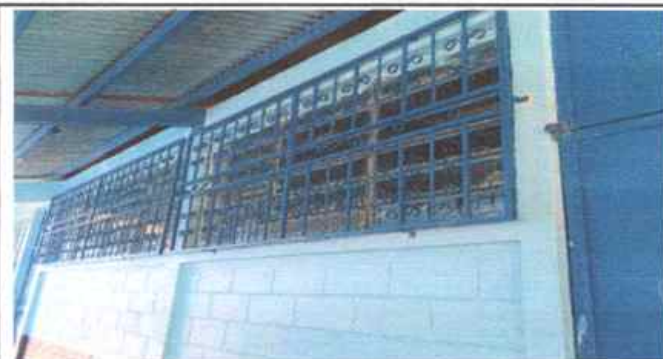
FOTO 2: SUSTITUCIÓN DE BALCONES DE METAL
