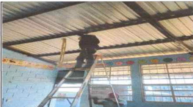
FOTO 3 CAMBIO DE PLAFONERAS
