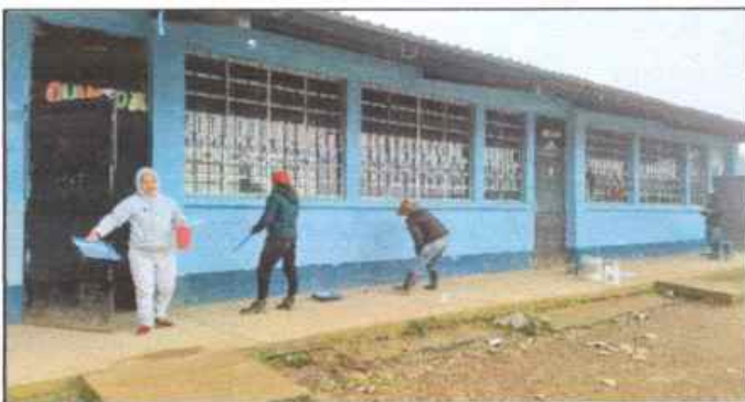
FOTO 5: PINTURA EN MUROS
