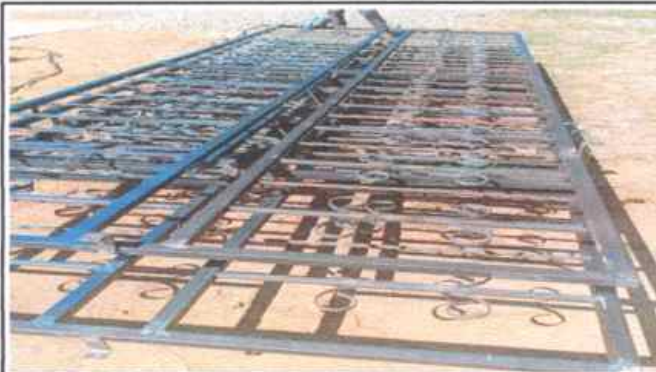
FOTO 2: SUSTITUCIÓN DE BALCONES DE METAL
