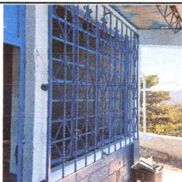
Foto 5: Mantenimiento a balcones de metal, lijado y aplicación de pintura.
