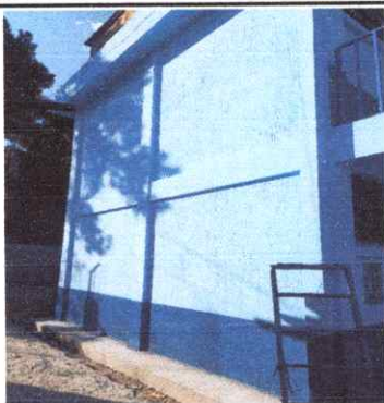
Foto 7: Aplicación de pintura en muro interior y exterior
