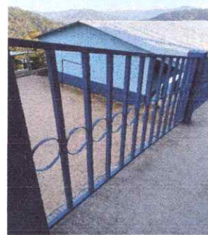
Foto 6: Mantenimiento a barandas de metal, lijado y aplicación de pintura.
