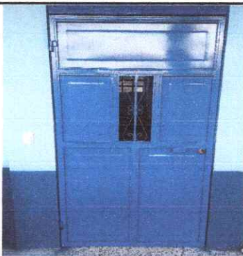
Foto 1: Mantenimiento de puertas de metal, lijado y aplicación de pintura.
