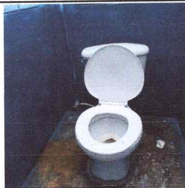
Foto 8: Sustitución de inodoro
