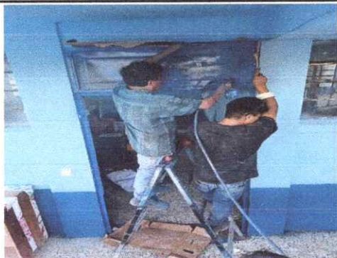
Foto1: Mantenimiento de puertas de metal, lijado y aplicación de pintura.
