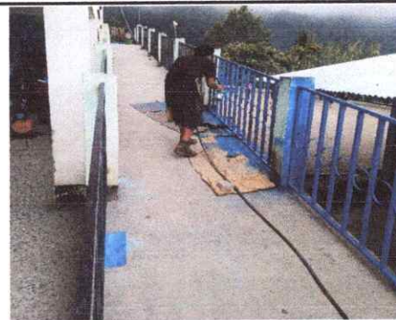
Foto 6: Mantenimiento a barandas de metal, lijado y aplicación de pintura.
