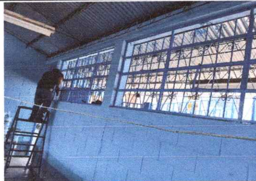
Foto 4: sustitución de estructura de metal de ventana de aulas, cocina, bodega y servicio sanitario.
