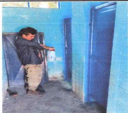
Foto 3: Sustitución de puertas de metal en servicio sanitario en mal estado
