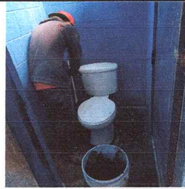
Foto 8: Sustitución de inodoro en servicio sanitario
