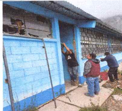
Foto 2: Sustitución de puertas de metal en mal estado
