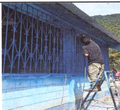
Foto 5: Mantenimiento a balcones de metal, lijado y aplicación de pintura.
