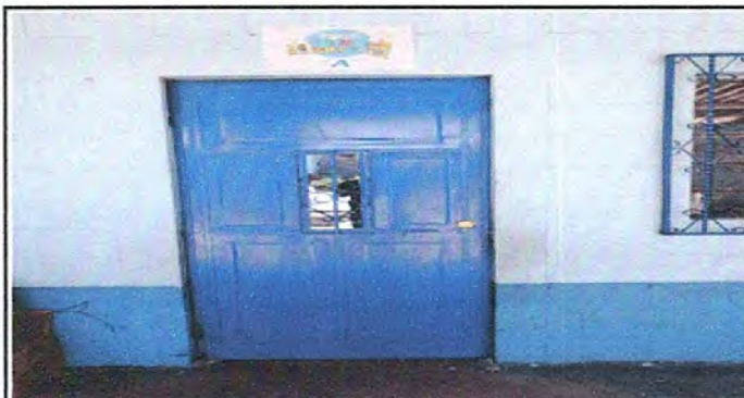
Foto 12. Sustitución de puertas de metal
