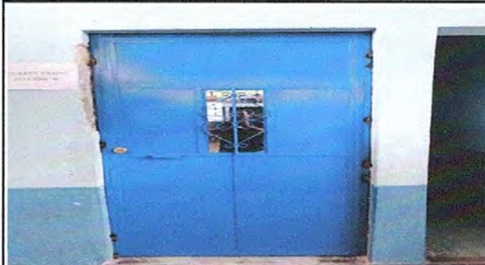
Foto 8. Sustitución de puerta de metal
