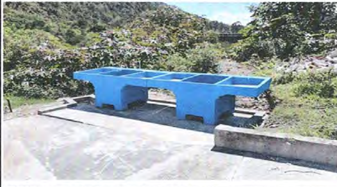
Foto 13. Pilas de cemento de dos lavaderos
