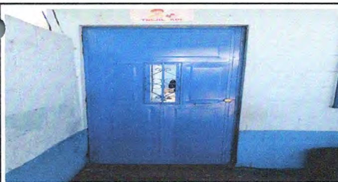
Foto 11. Sustitución de puertas de metal
