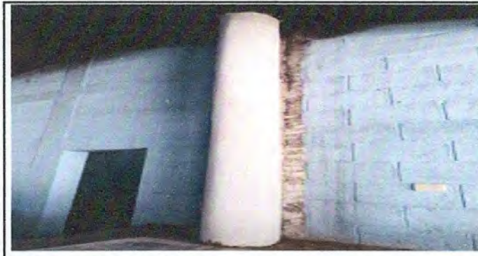
Foto 6. Chimenea de estufa rural
