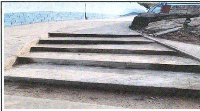
Foto 2. Rampa para módulos planta baja
