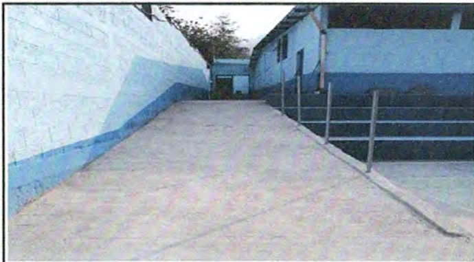
Foto 1. Rampa para cancha polideportiva
