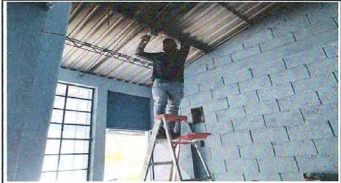
Foto 2. Instalación de plafoneras y focos, planta baja.
