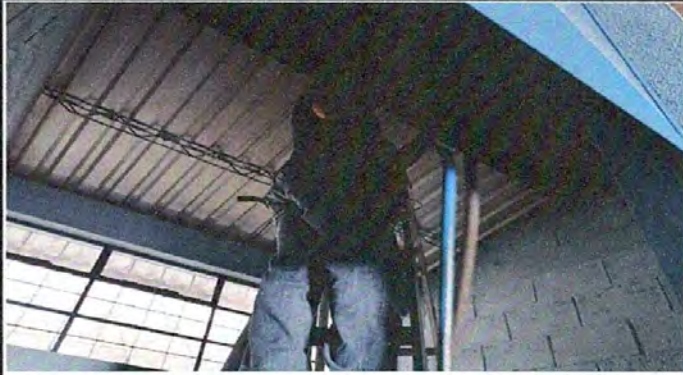
Foto 1. Instalación de cableado eléctrico, planta baja.
