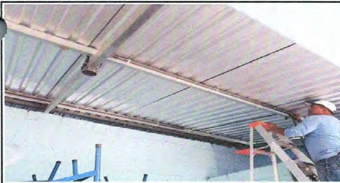
Foto 5. Instalación de cable eléctrico para plafoneras en corredor, planta baja.
