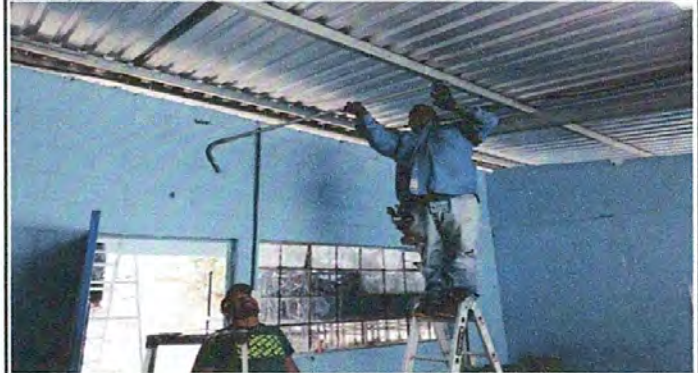
Foto 4. Instalación de cable eléctrico para plafoneras en el aula, planta baja.
