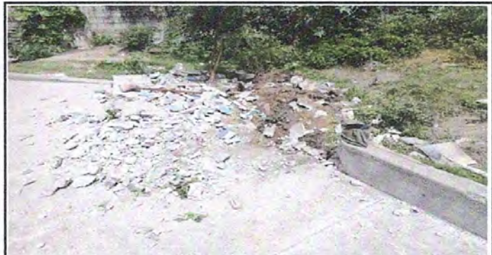
Foto 12. Pilas de cemento de dos lavaderos
