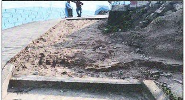
Foto 2. Rampa módulos planta baja
