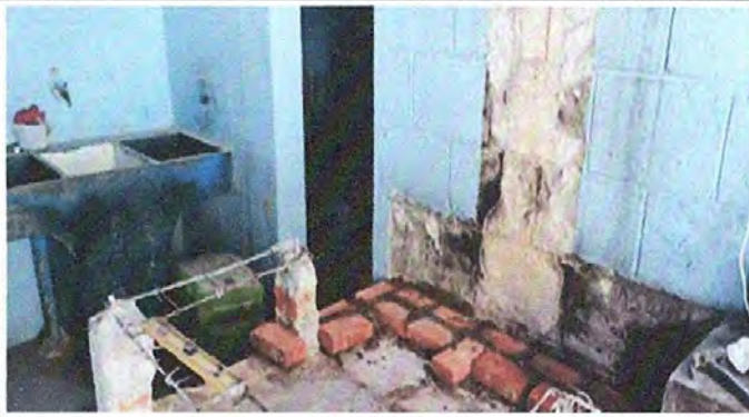
Foto 7. Chimenea de estufa rural
