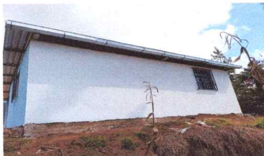
Foto 6: Canales y bajadas de agua Pluvial
