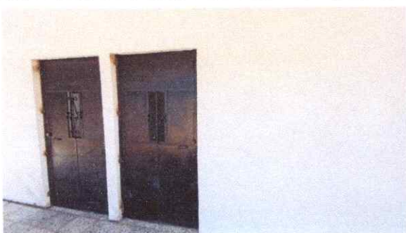
Foto 3: Puertas de metal
