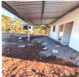
Foto 2: Estructura de Techo
