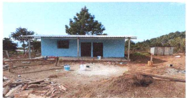
Foto 2: Pintura en muros exteriores e interiores
