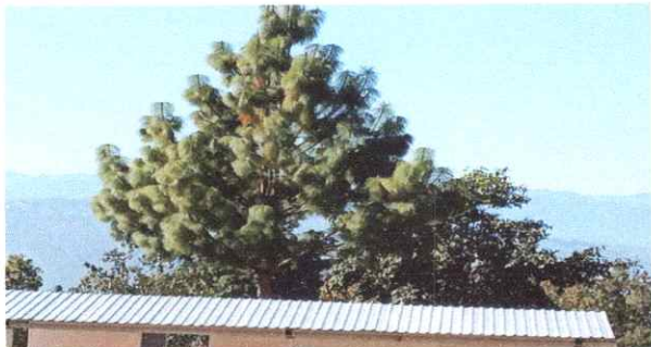
Foto1: cubierta de lámina
