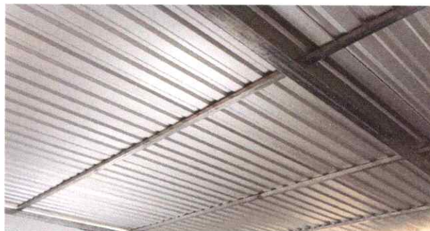
Foto 2: Estructura de Techo
