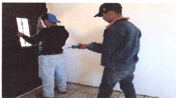
Foto 3: Puertas de metal
