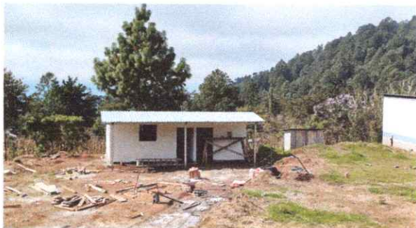
Foto1: cubierta de lámina
