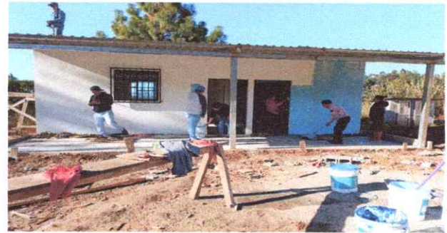
Foto 2: Pintura en muros exteriores e interiores
