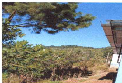
Foto 6: Canales y bajadas de agua Pluvial
