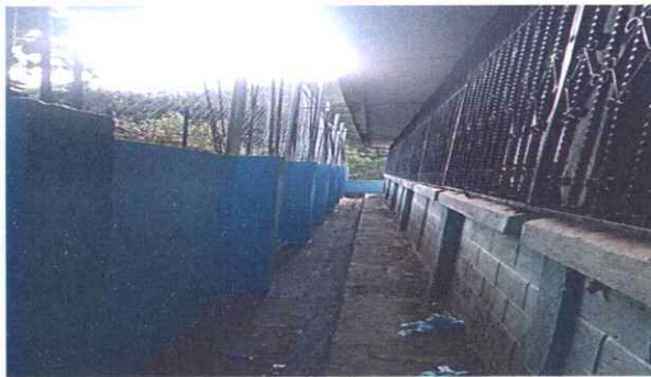
Foto 6: Instalacion de drenaje culminado
