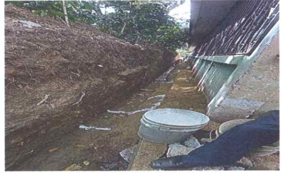
Foto 2: Preparación del cemento.
