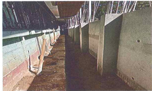
Foto 6: Preparación de la cuneta.
