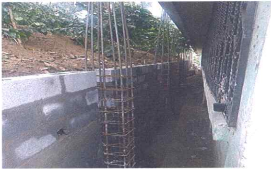
Foto 3: 50 % del levantada del muro.
