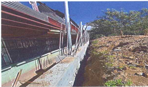
Foto 5: 75 % del vantage del muro.
