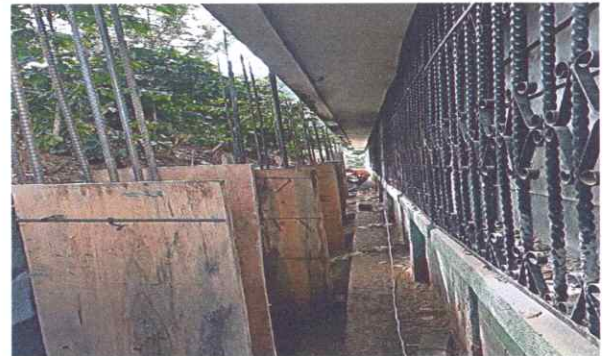
Foto 4: Preparación de las columnas.
