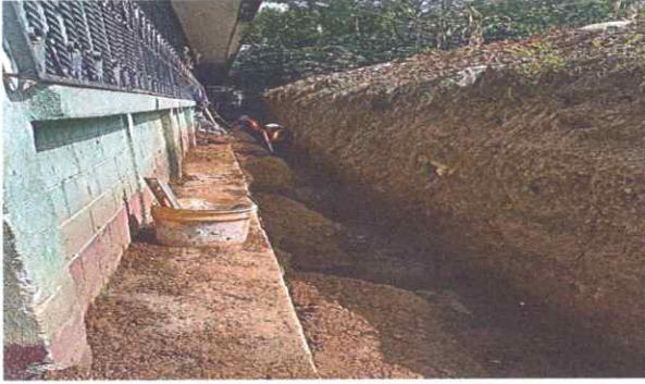
Foto1: Escobación del muro.
