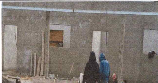
FOTO 2: MEJORAMIENTO DE PAREDES
