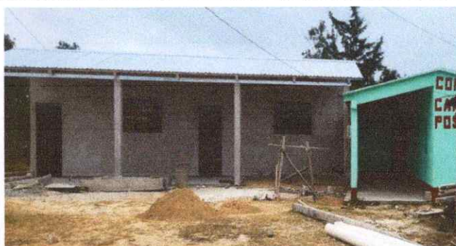
FOTO 6: REPARACIÓN DE PAREDES
