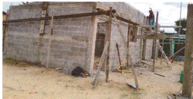
FOTO 2: MEJORAMIENTO DE PAREDES
