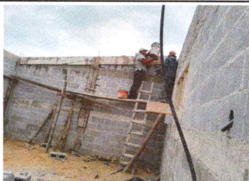
FOTO 6: REPARACIÓN DE PAREDES
