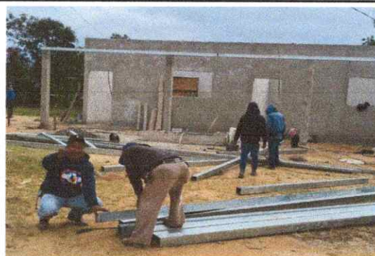
FOTO 4: SUSTITUCIÓN DE ESTRUCTURA DE SOPORTE DE TECHO
