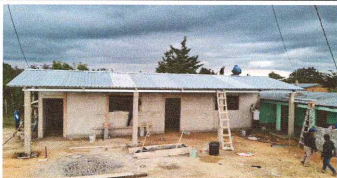
FOTO 3: SUSTITUCIÓN DE VENTANAS DE MADERA POR METAL
