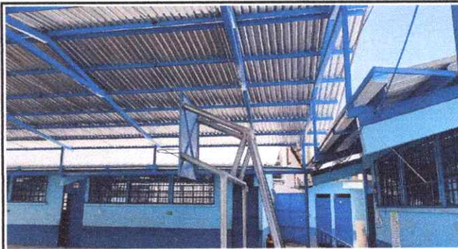
Foto 4: Terminación de colocación de canal entre las aulas
