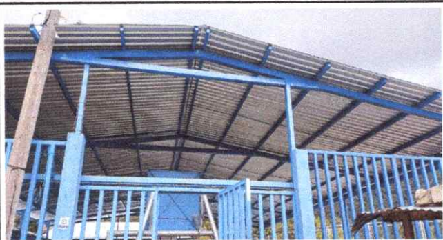
Foto 1: Terminación de cubierta de lámina Troqueda calibre 26
