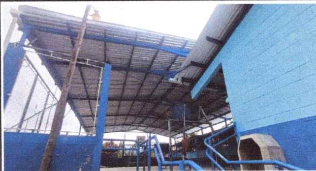
Foto 2: Cubierta de lámina completa
