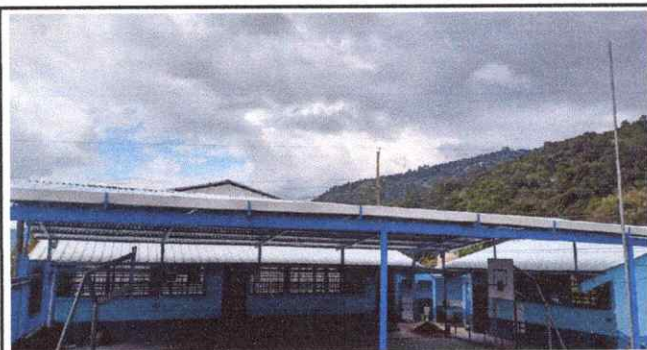
Foto 3: Terminación de soporte o pescante de metal para canal y terminación de colocación de canal
