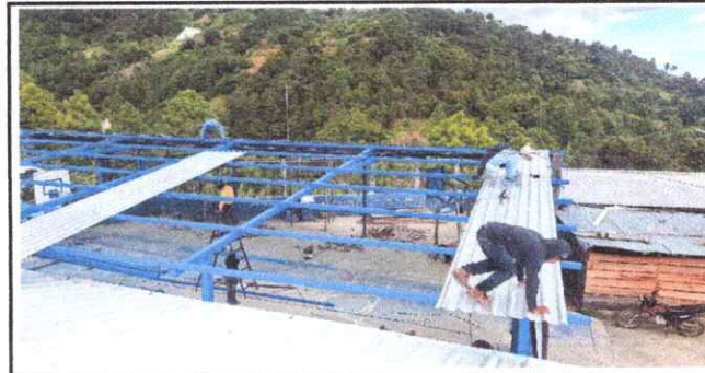
Foto 6: Cubierta de lámina troquelada calibre 26 para terminación del techado
