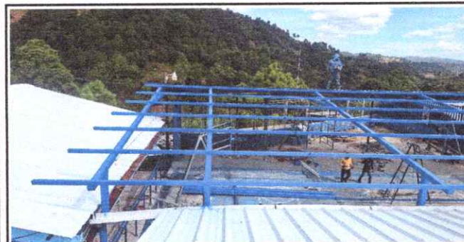
Foto 5: Cubierta de lámina troquelada calibre 26 del lado derecho
