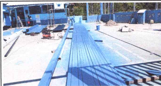
Foto 1: Pintada de estructura de soporte de metal y Colocación de las bases
