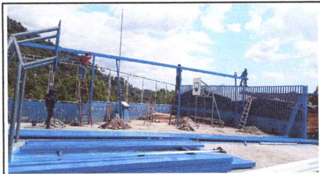
Foto 3: Colocación de las bases de estructura de soporte de metal
