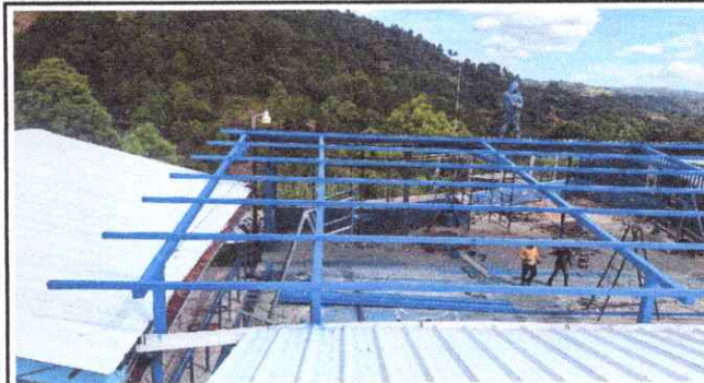
Foto 4: Terminación de estructura de techo de soporte de metal
