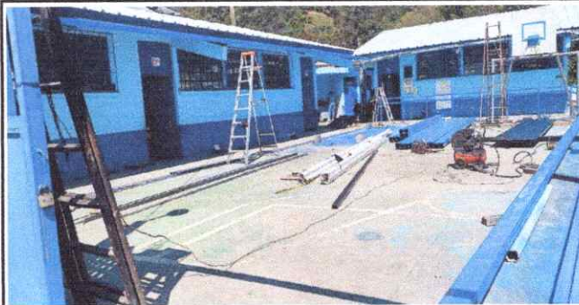
Foto 2: Levantada de estructura de soporte de metal
