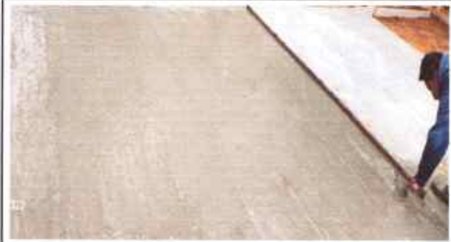
Foto 8: SUSTITUCIÓN DE PISO DE TORTA DE CONCRETO (NUEVO RENGLÓN)
