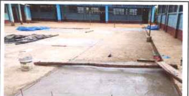
Foto 6: SUSTITUCIÓN DE PISO DE TORTA DE CONCRETO
