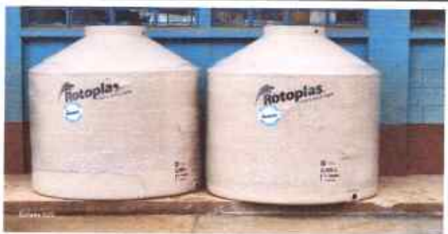
Foto 5: SUSTITUCIÓN DE DEPÓSITO DE AGUA 2500 LTS
