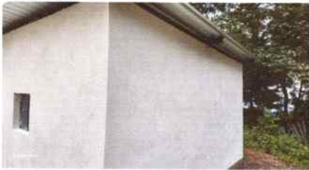
Foto 7: REPELLO EN MURO
