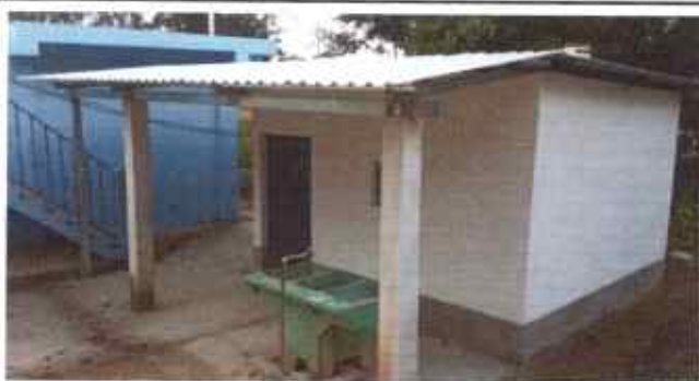
Foto 3: SUSTITUCIÓN DE LÁMINA, POR LÁMINA TROQUELADA ALUZINC CALIBRE 24
