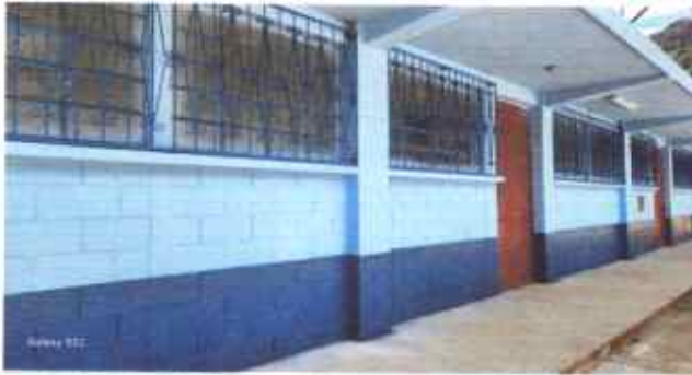
Foto1: SUSTITUCIÓN DE BALCONES DE METAL
