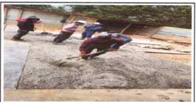
Foto 6: SUSTITUCIÓN DE PISO DE TORTA DE CONCRETO
