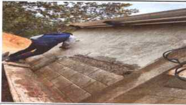
Foto 7: REPELLO EN MURO
