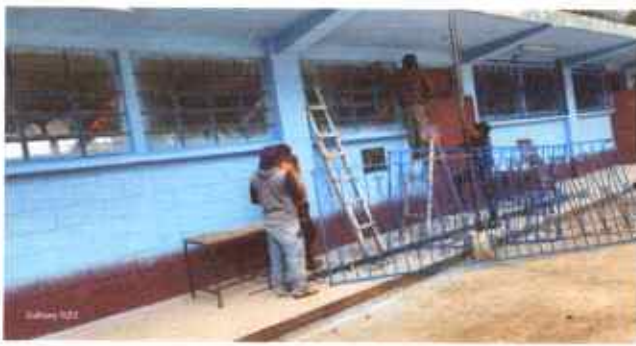
Foto 1: SUSTITUCIÓN DE BALCONES DE METAL
