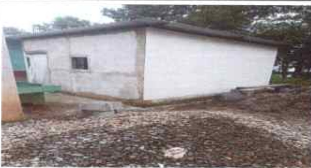
Foto 3: SUSTITUCIÓN DE LÁMINA, POR LÁMINA TROQUELADA ALUZING CALIBRE 24
