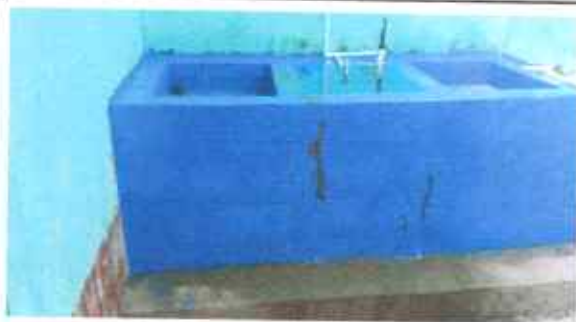
Foto 9: SUSTITUCIÓN DE PILA POR PILA DE CEMENTO DE DOS LAVADERAS
