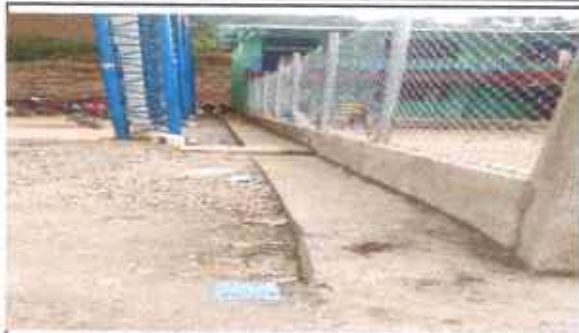
Foto 1: SUSTITUCIÓN DE LA CIRCULACIÓN
