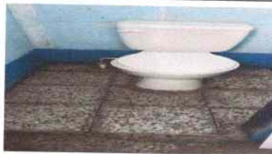
Foto 8: REPARACIÓN DE INODORO CON ACCESORIOS
