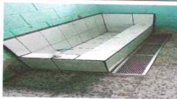
Foto 10: REPARACIÓN DE DRENAJES
