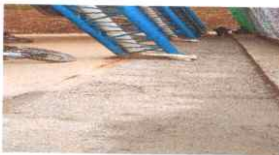
Foto 14: SUSTITUCIÓN DE CUNETA
