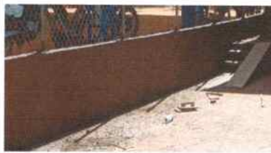
Foto 2: SUSTITUCIÓN DE MURO DE CONTENCIÓN
