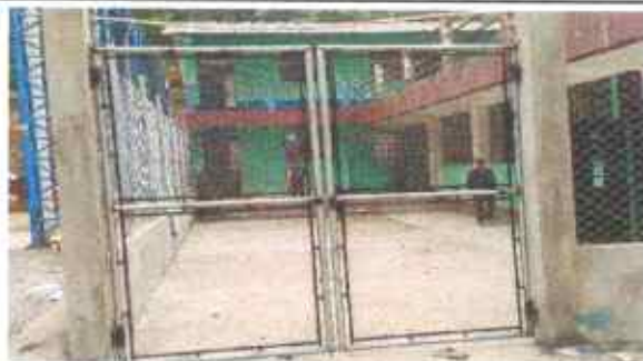
Foto 3: SUSTITUCIÓN DE PORTÓN
