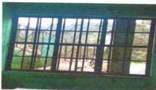
Foto 11: SUSTITUCIÓN DE ESTRUCTURA DE VENTANA
