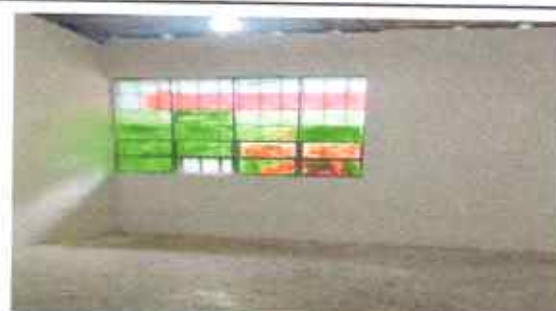
Foto 12: REPELLO EN MURO
