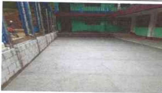
Foto 7: SUSTITUCIÓN DE PISO
