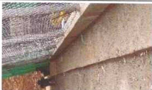
Foto 13: SUSTITUCIÓN DE BANQUETA
