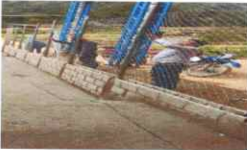
Foto 1: SUSTITUCIÓN DE LA CIRCULACIÓN CON TUBO HG Y MALLA GALVANIZADA
