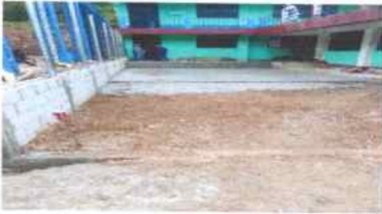
Foto 7: SUSTITUCIÓN DE PISO DE CERÁMICA POR PISO DE TORTA DE CONCRETO
