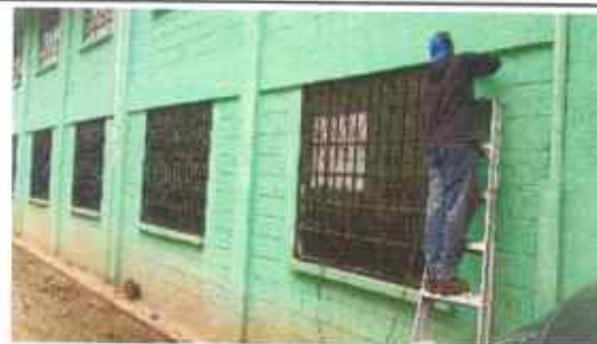
Foto 6: MEJORAMIENTO DE VENTANA CON BALCÓN
