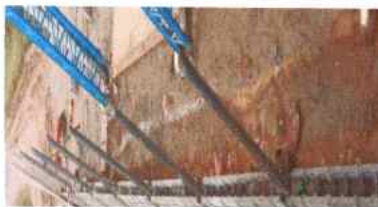
Foto 14: SUSTITUCIÓN DE CUNETETA
