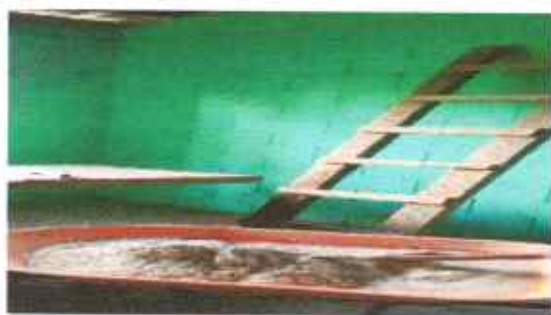
Foto 15: REPELLO EN MURO
