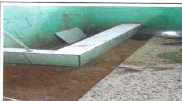
Foto 10: REPARACIÓN DE DRENAJES
