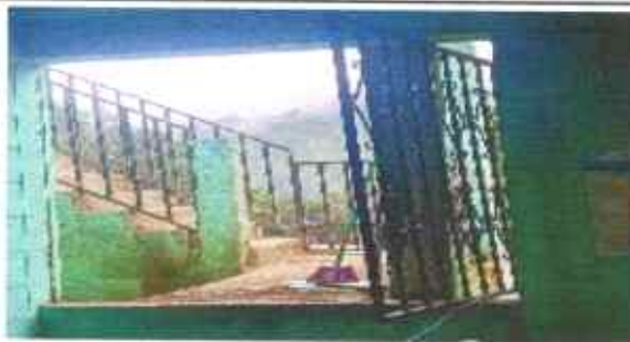
Foto 11: SUSTITUCIÓN DE ESTRUCTURA METÁLICA DE VENTANA
