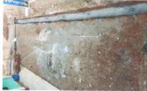
Foto 2: SUSTITUCIÓN DE MURO DE CONTENCIÓN
