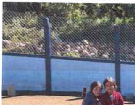
Foto 4: REPARACIÓN DE MURO PERIMETRAL
