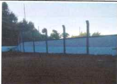
Foto 3: REPARACIÓN DE MURO PERIMETRAL
