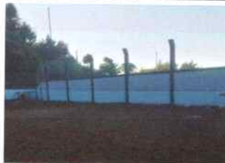
Foto 2: PINTURA EN MUROS PERIMETRALES
