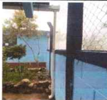
Foto 6: REPARACIÓN DE BAJADAS DE AGUA PLUVIAL
