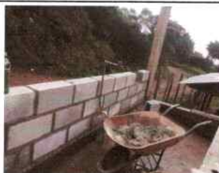
Foto 4: REPARACIÓN DE MURO PERIMETRAL
