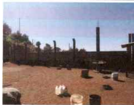
Foto 2: PINTURA EN MUROS PERIMETRALES
