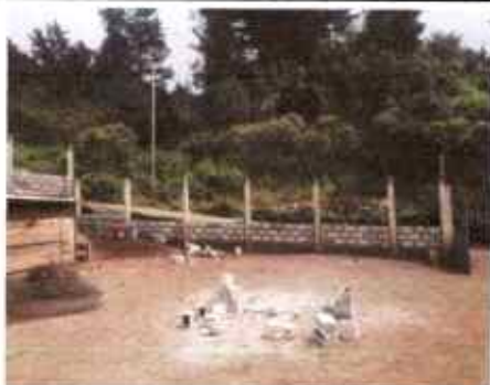
Foto 3: REPARACIÓN DE MURO PERIMETRAL
