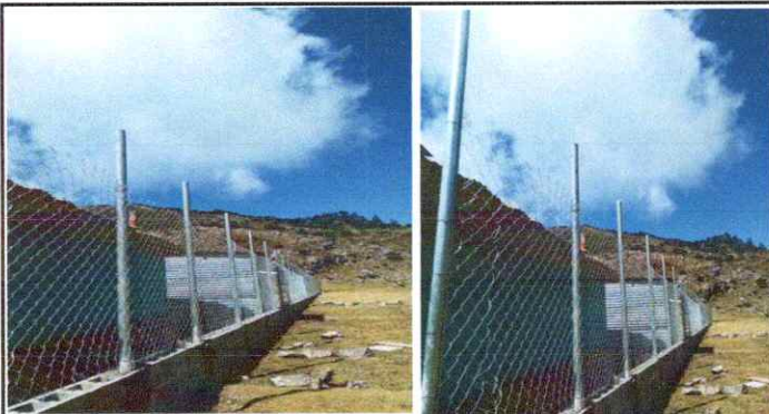
Foto 3: REPARACION DE MURO PERIMETRAL DE BLOCK CON TUBO HG Y MAYA GALVANIZADA
