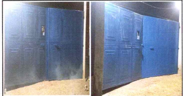
Foto 4: SUSTITUCION DE PORTON DE METAL
