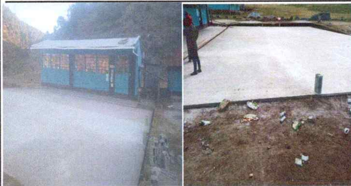
Foto1: REPARACION DE PISO DE TORTA DE CONCRETO.
