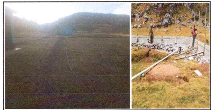
Foto 6: SUSTITUCION DE TUBERIA PVC LINEA PRINCIPAL DE AGUAS NEGRAS
