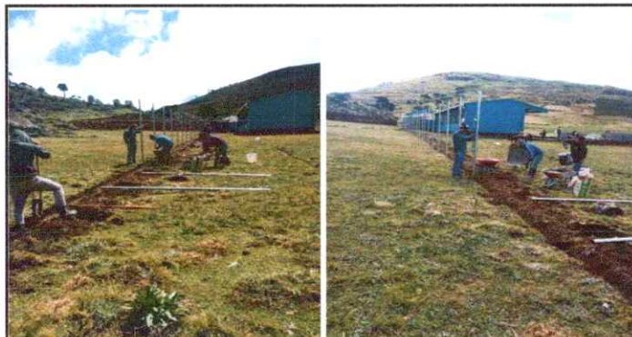
Foto 3: REPARACION DE MURO PERIMETRAL DE BLOCK CON TUBO HG Y MAYA GALVANIZADA
