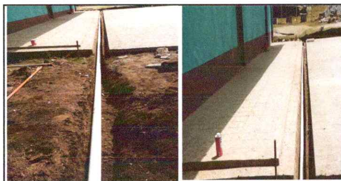
Foto 5: SUSTITUCION DE TUBERIA PVC LINEA PRINCIPAL DE AGUAS PLUVIALES
