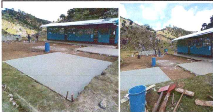
Foto1: REPARACION DE PISO DE TORTA DE CONCRETO.
