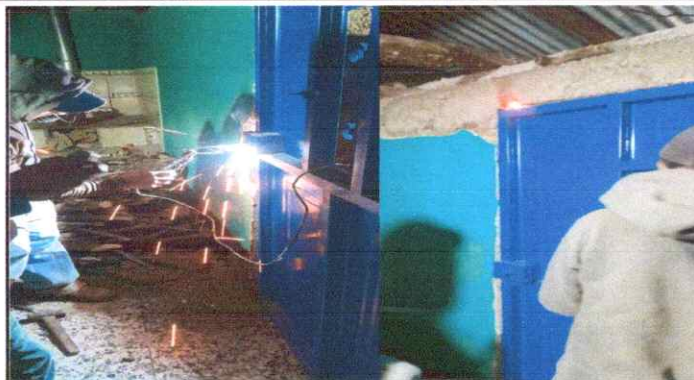
Foto 2: SUSTITUCION DE PUERTA
