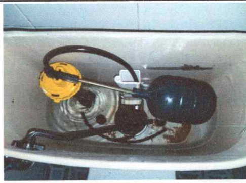
Foto 6: Sustrucción kit de accesorios de sanitarios
