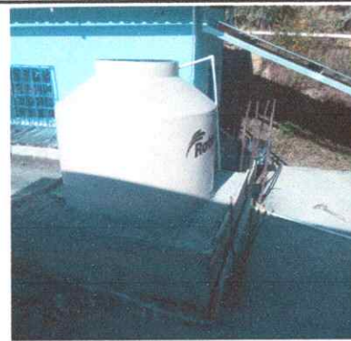
Foto 4: Reparación y mantenimientos de cisternas/depósito de agua
