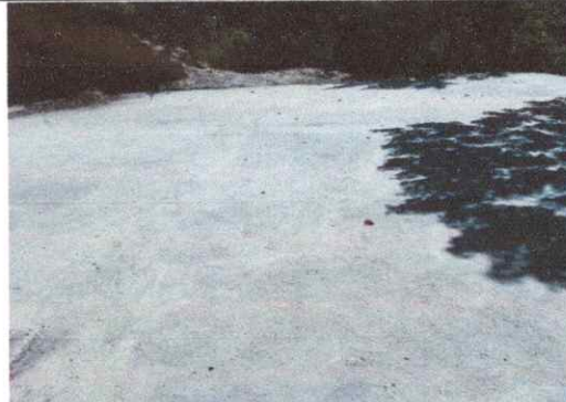
Foto 2: Reparación de piso de torta de concreto
