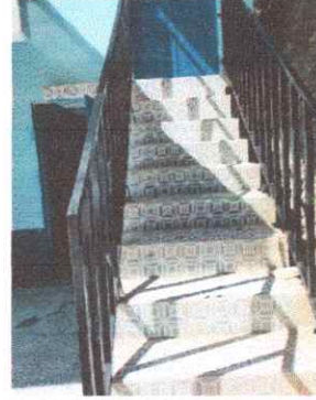
Foto 8: Sustitución de baranda de metal
