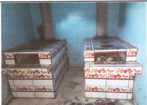
Foto 5: Sustrucción de estufa rural
